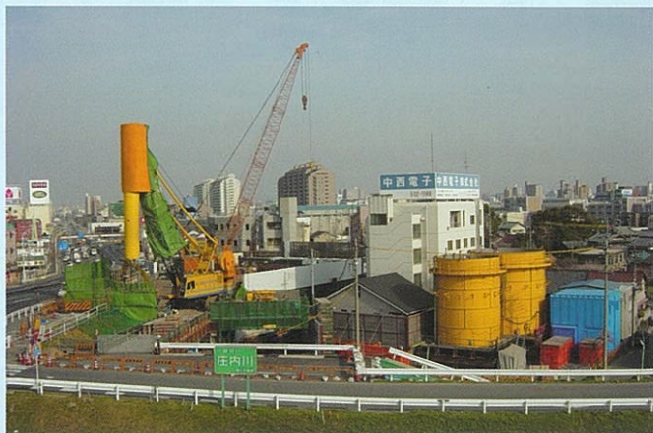
地中連続壁基礎施工状況
