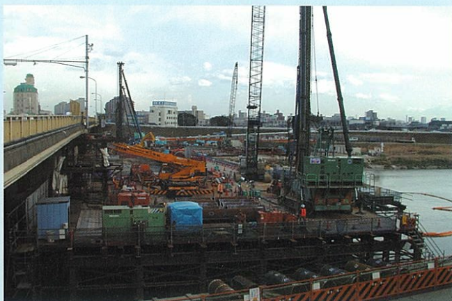
鋼管矢板基礎施工状況
